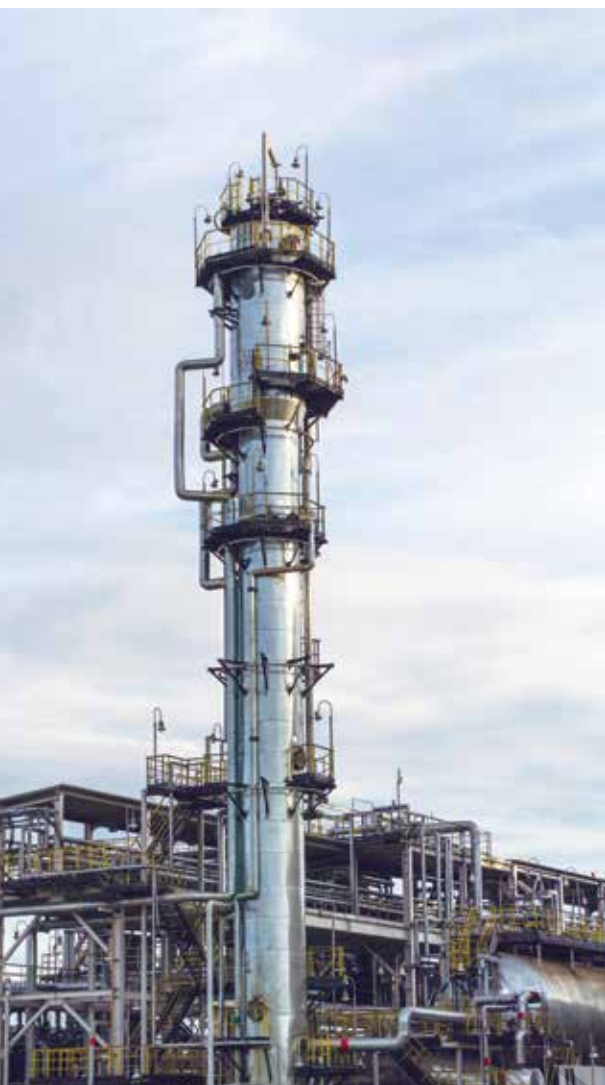
الشكل (20): برج التكسير الحراري.
